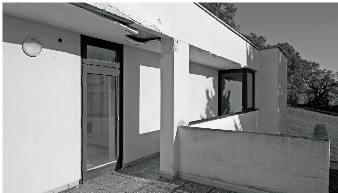
Zustand vor der Renovierung FOTOS: RAINER SCHODITSCH PHOTOGRAPHY
