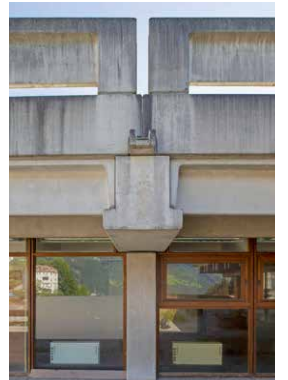
Kongresszentrum, Detailsicht der Erdgeschoszone
