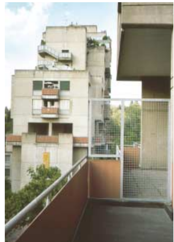
Absperrung im 4. Geschoß – Kommunikationsebene
