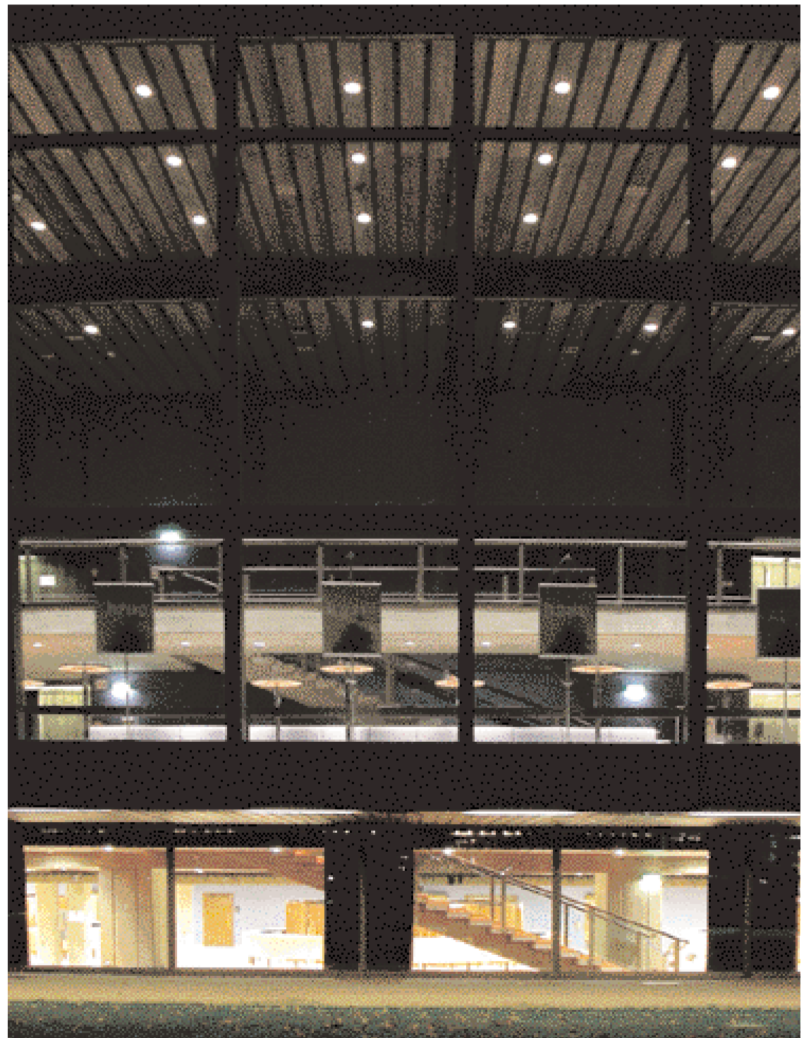
Blick in das sanierte Foyer
