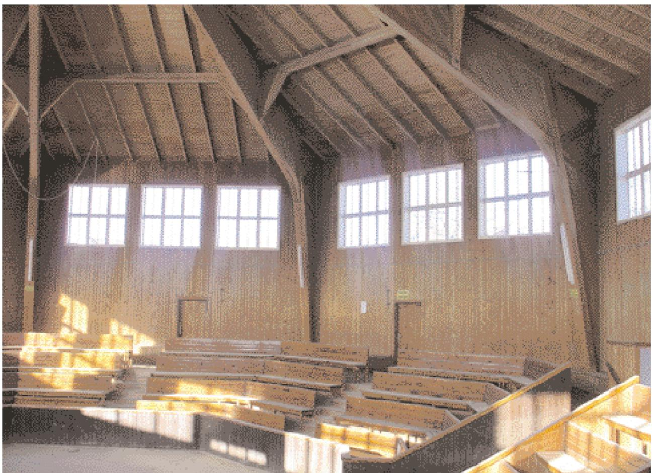
Die Rotunde ist als reine Holzkonstruktion in Fertigbauweise ausgeführt. Fotos: Richard Woschitz
