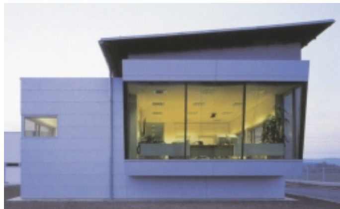
Hans Schandl: Kläranlage in Schützen
