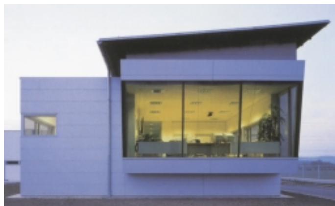
Hans Schandl: Kläranlage in Schützen
